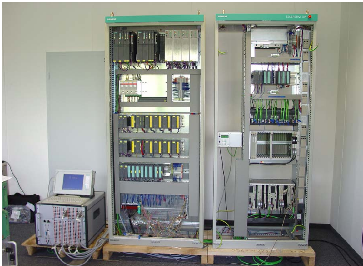
Bild 1: Simulator (links) mit Turbinenregler
